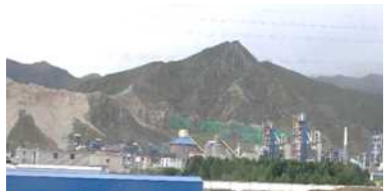
写真2 石灰石鉱山(左)とプラント(右)
