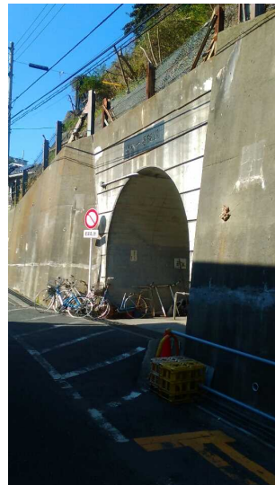
図2 汐入町の防災トンネル
